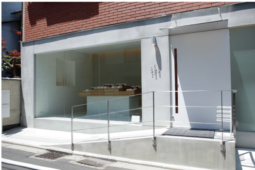
京あめ「クロッシェ」外観
